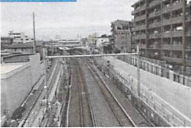
①西谷駅付近
